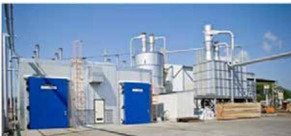
写真右の装置がバイオマスボイラー。製材工程でできた木屑・皮・おがくずなどを燃料とし、製品の乾燥熱源として利用している
